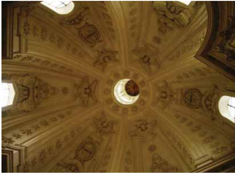
Francesco Borromini. Interior de la innovadora cúpula de la iglesia de San Ivo alla Santa Sapienza en Roma, con forma de hexágono estrellado de perfil mixtilíneo para adaptarse a la planta del edificio.
