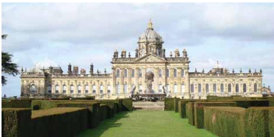
Castillo Howard. Edificio rectangular presidido por un pórtico clasicista sobre el que se impone una gran cúpula semiesférica con linterna sobre elevado tambor.
